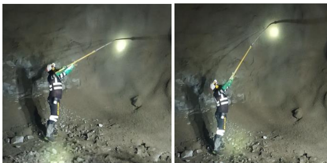
Figura 2. Calibración de shotcrete en los hastiales de la labor
