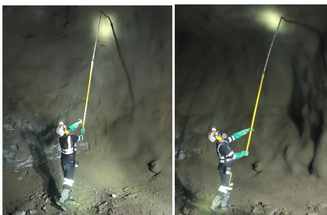
Figura 3. Calibración de shotcrete en la corona de la labor
