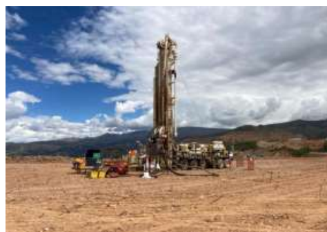
Fig. 5 Se muestra la perforadora SCHRAAM T-130 trabajando en el pad 1A.
