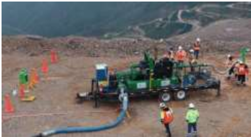
Fig. 10 Equipo de inyección.
