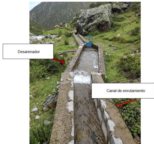
Fig. 4 Canal de enrutamiento
