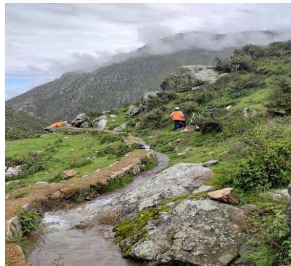
Fig. 5 Canal amunero Senega–Tambo (primer tramo) en el distrito de San Pedro de Casta, provincia de Huarochirí, Lima.
