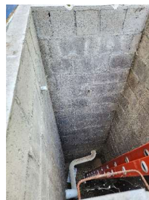
Fig. 7 Vista interna del pozo de registro utilizado para las mediciones.
