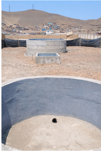
Figura 4: Vista completa del biodigestor terminado.
