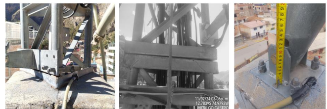
Fig. 02 unión de la base, unión entre los tramos a 3 metros y el arrioste, visualización de izquierda a derecha respectivamente.
