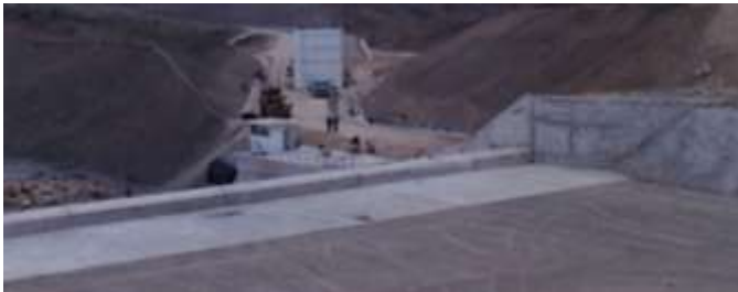
Fig. 6 Vertedor de emergencia o auxiliar: Longitud de cresta 50 metros, paramento 1.20 metros y cota de cresta 45.50 msnm.
