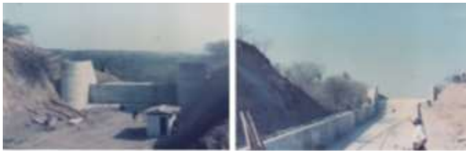
Fig. 5 Vertedor de servicio: Paramento y rápida de empate con el río El Azúcar. Longitud de cresta 16 metros, paramento 4 metros y cota de cresta 45.00 msnm.
