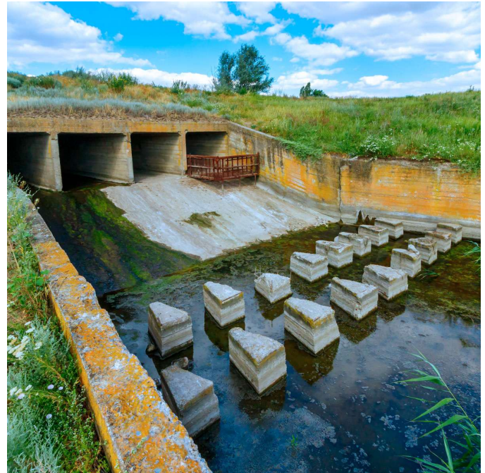
Fig. 1 Dissipador de energía hidráulico compuesto por bloques de concreto dispuestos en una sección de canal de desagüe (Fuente: Fabricum PUCP)
