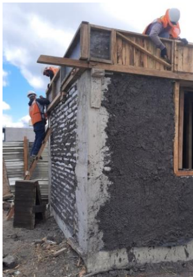
Fig. 4 Vista de pared con superadobes en bolsas, columna de cemento, y pared con revoque grueso.
