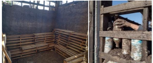
Fig. 1 Estructura de pallets con botellas y pallets para piso
