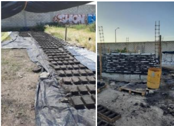
Fig. 3 Preparación de adobes, foto izquierda y Superadobes en bolsas, foto derecha.
