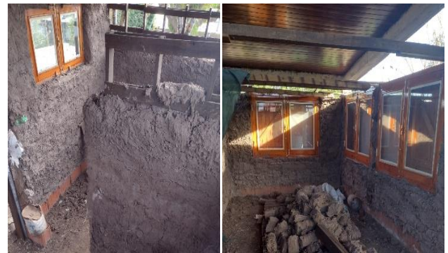
Fig. 2 Pared interna modelado directo, foto izquierda; Adobes y ventanas, foto derecha.
