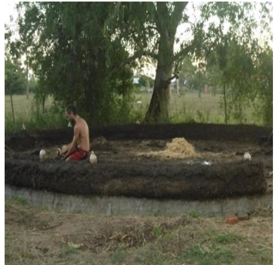
Fig. 5 Levantamiento de paredes con modelado directo y ecoladrillos intercalados.
