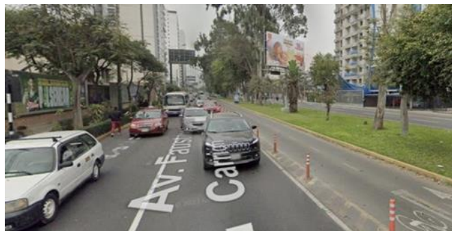
Fig. 3 Construcción de ciclovía en el tercer carril de la avenida
