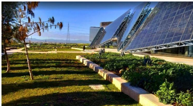
Fig. 2 Edificio BIPV en la Universidad de Chipre.
