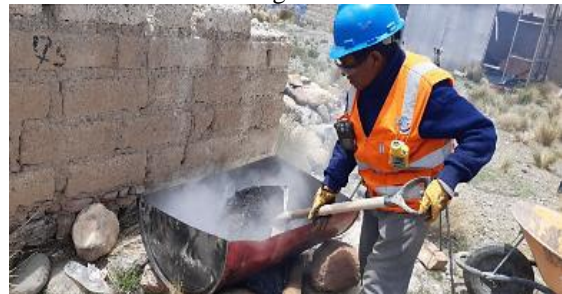
Fig. 1. Equipos de seguridad básicos.
