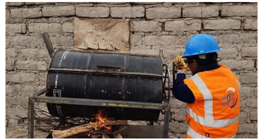
Fig. 5 Uso de la mezcladora de asfalto
