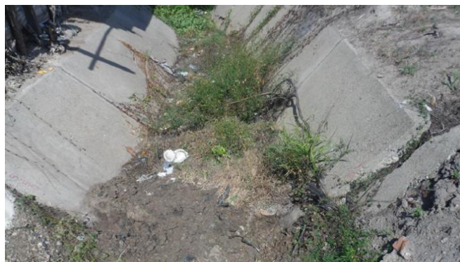
Figura 1. Canal con obstrucciones. Fuente: Propia
