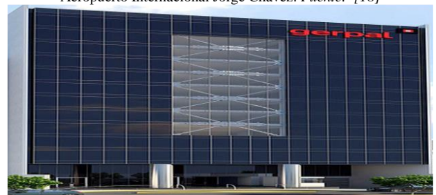
Figura 3: Utilización de disipadores tipo fluido viscoso en el Centro Empresarial Reducto. Fuente: [18].
