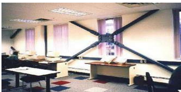
Figura 7: Disipador Histeréticos por fricción. Fuente : [20]
