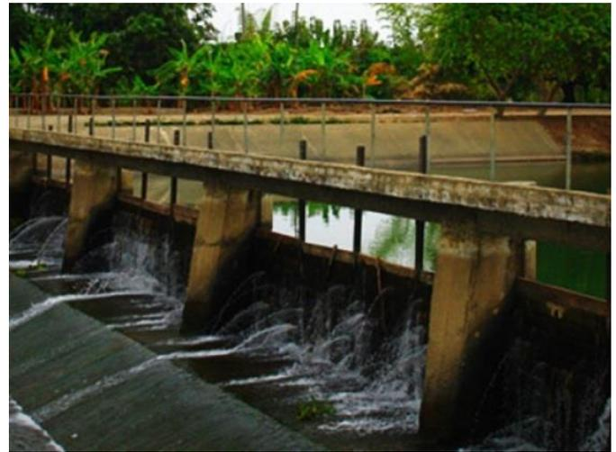
Fig. 3 Compuerta de tablonces en el río Chilintomo
