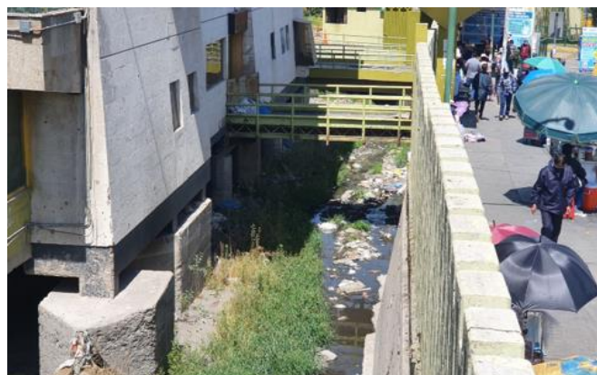
Fig. 8 Infraestructuras presentes en el cauce de la torrentera Los Incas (Terminal Terrestre).
