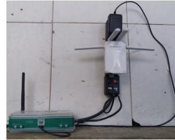
Fig. 13 Instalación del nodo recolector. Fuente: Autor
